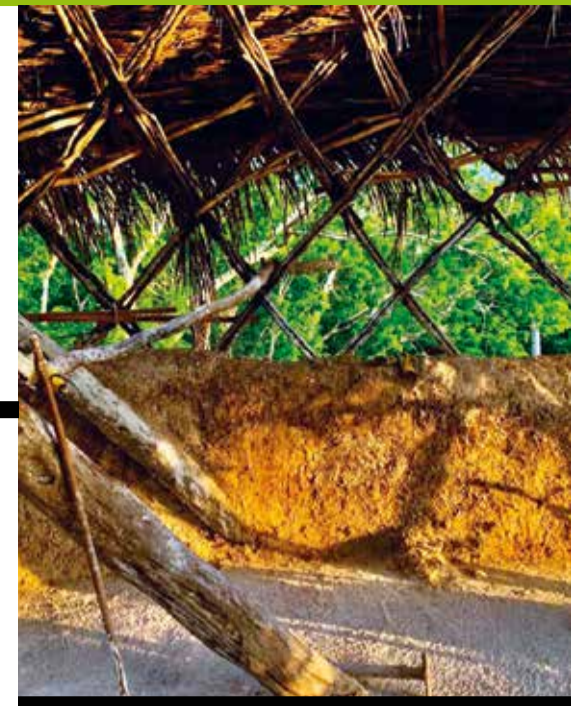
Detalle del muro hecho con Hemp.
